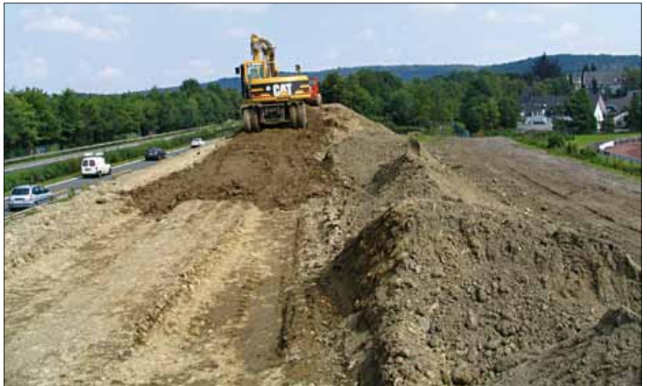
Aufhöhung eines Lärmschutzwalls mit Aushub aus den Renaturierungen
